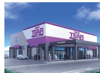
● ティア養老 岐阜県養老郡養老町
