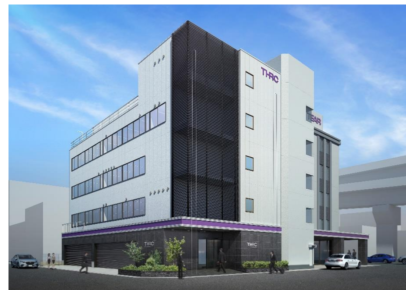
2019年4月より稼働する教育施設 ティア・ヒューマンリソース・センター
